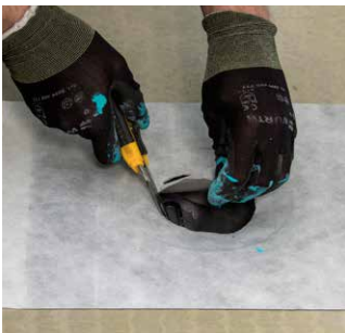
5. Leikkaa mattopuukolla keskialue pois. Paina kiristysrenkas varovasti paikoilleen.
