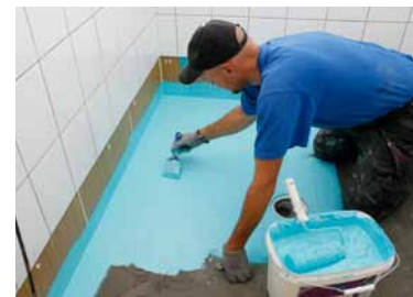
20. Kiilto Kerafiber vedeneriste telataan kauttaaltaan yli koko lattiapinnan. Ensimmäisen telauksen annetaan kuivua vähintään 2 h (värimuutos). Toisen levityksen jälkeen odotetaan väh. 6 h (värimuutos) ennen laatoitusta. Vedeneristeen kuivakalvonpaksuus lattiassa väh. 0,5 mm.
