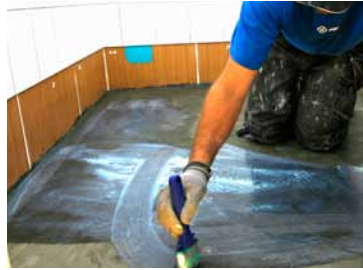
13. Kiilto Keraprimer levitetään kuivalle tasoitetulle lattialle 1 : 1 vedellä ohennettuna. Kuivuminen väh. 1 tunti.
