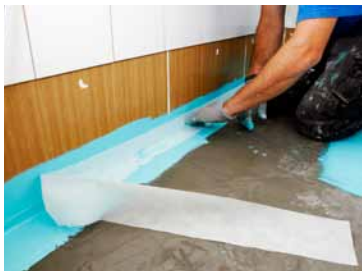
15. Nurkkavahvikenauha painetaan kiinni tuoreeseen vedeneristeeseen ja varmistetaan vahvikkeen läpivettyminen sivelemällä vedeneristettä myös nauhan päälle.
