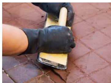
23. Lattiat saumataan esim. Kiilto Saumalaastilla. Saumalaasti levitetään kumilastalla painaen saumat täyteen. Ylimääräinen laasti pestään 15-30 min kuluttua.
