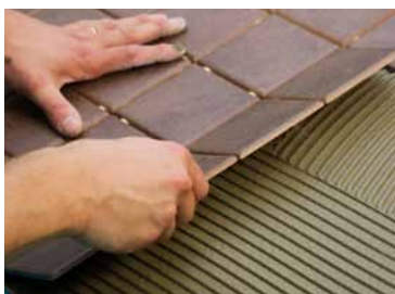
22. Lattialaatat kiinnitetään esim. Kiilto Saneerauslaastilla.
